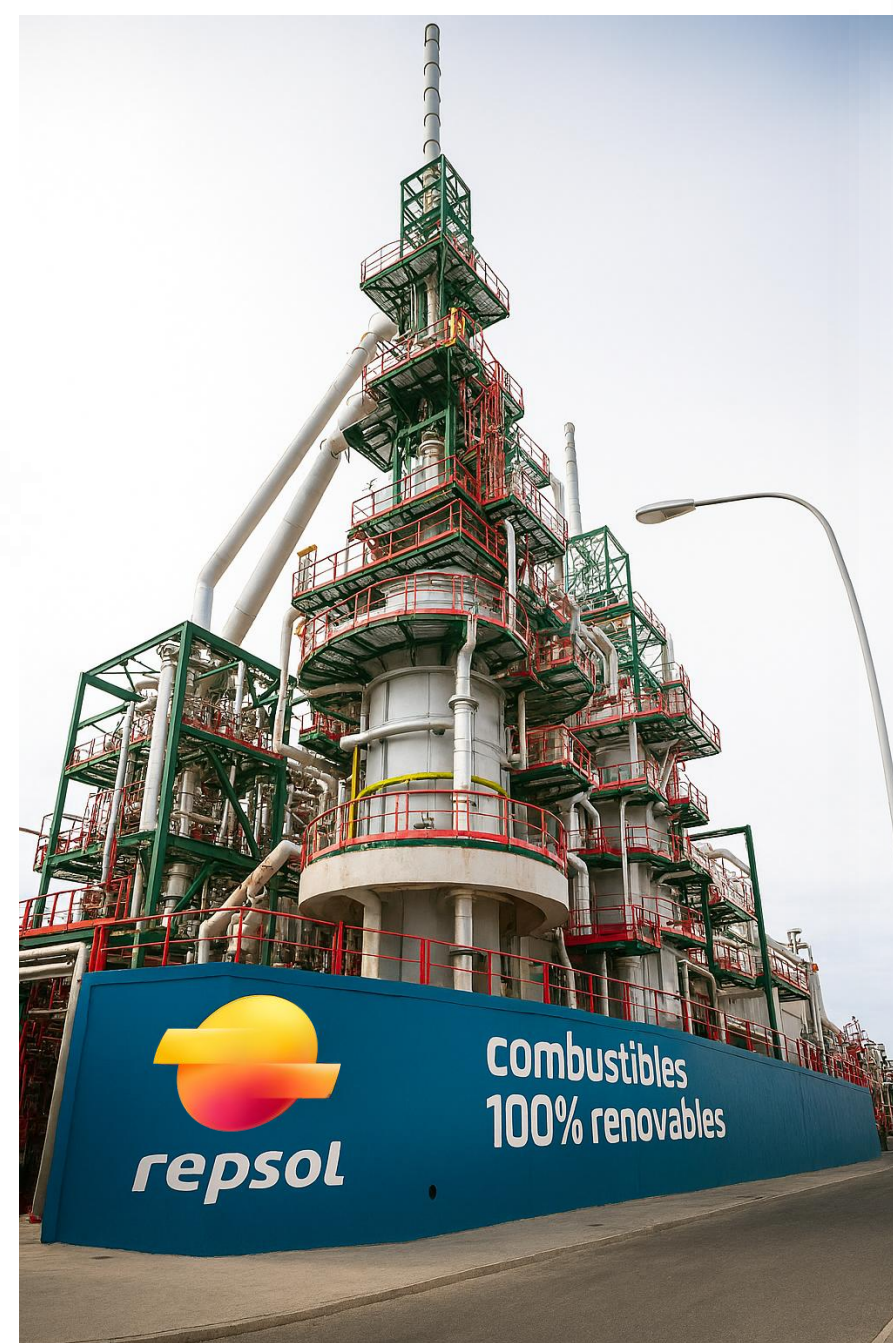
Repsol C43. Primera planta completamente dedicada a la fabricación de biocombustibles 100% renovable de la península Ibérica a escala industrial.
