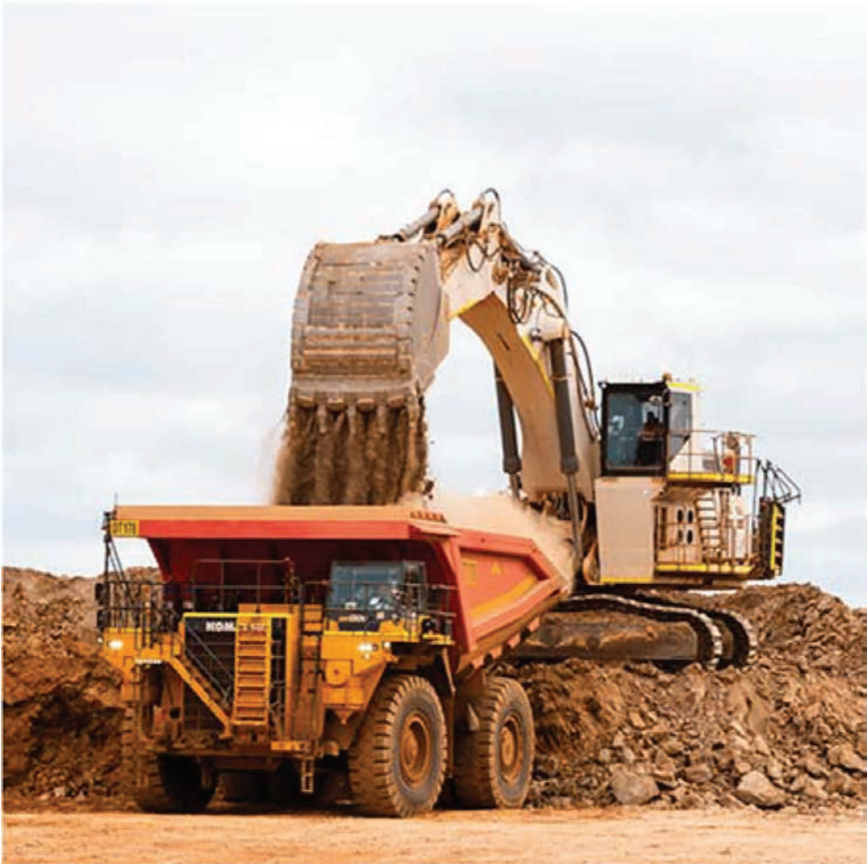
Imagen 5.– Obras de ingeniería civil, Australia
